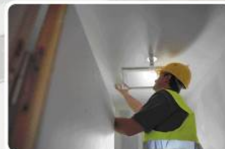
Vérification des jointures
