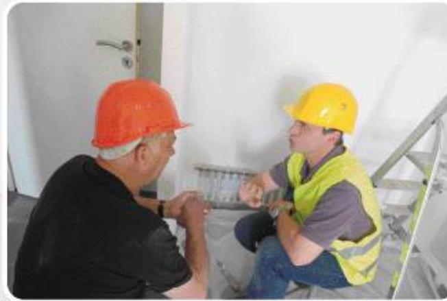
Contrôler l'étanchéité à l'air
